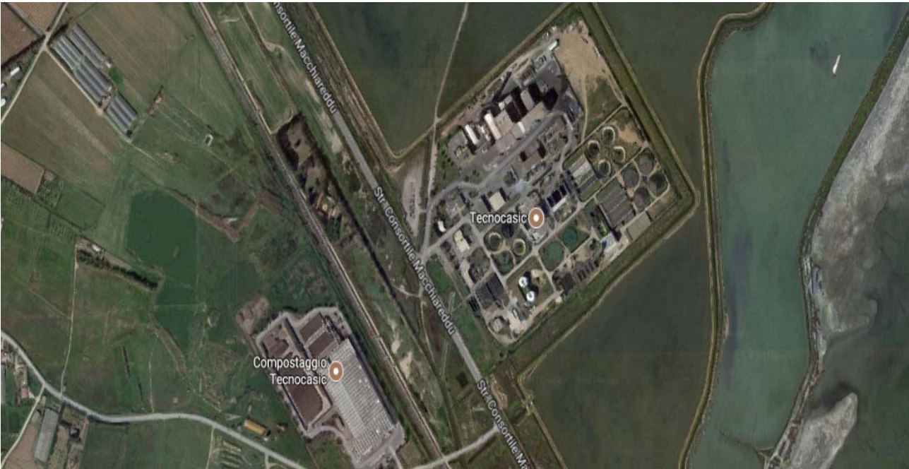
Figura 5 - Ortofoto satellitare dell'impianto di termovalorizzazione
