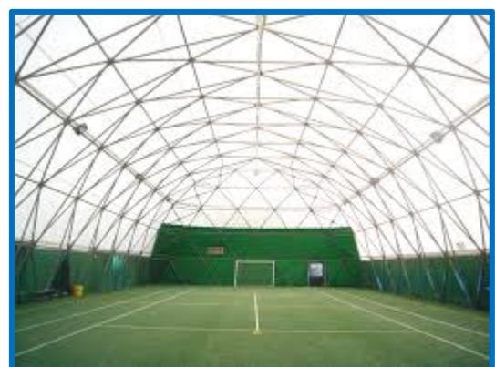
Esempio di Struttura Geodetica
